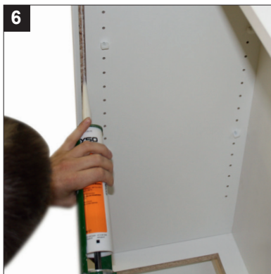
LED Lichtschiene mit Leim in der Nut befestigen
