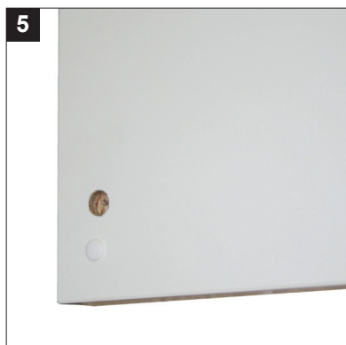
Bohrloch in der Türe Ø8 mm, Tiefe 5 mm für Permanent-Magnet. Muss mit Magnet- sensor abgestimmt sein. Kontaktabstand max. 18 mm.
