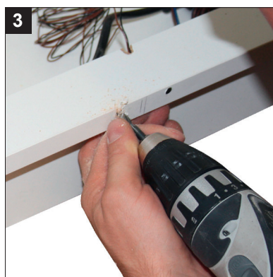
Bohrloch für Magnetsensor Ø 5.6 mm. Muss mit Permanent-Magnet in der Türe abgestimmt sein. Kontaktabstand max. 18 mm.
