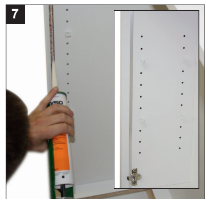
Flachprofil mit Leim in der Nut befesti- gen. (Kabel-Anschluss unten)
